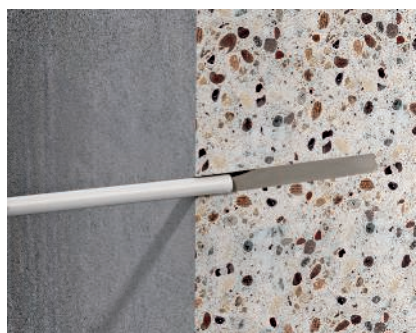
Aplikacja zaprawy iniekcyjnej Wtryskiwanie zaprawy do otworu
