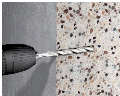
Wiercenie Przygotowanie otworu odpowiedniej średnicy
