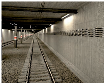
Wanienki kablowe są stosowane w miejscach z ograniczoną ilością miejsca, takich jak metro czy tunele kolejowe.
