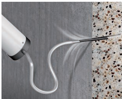
Czyszczenie otworu Wydmywanie otworu sprężonym powietrzem
