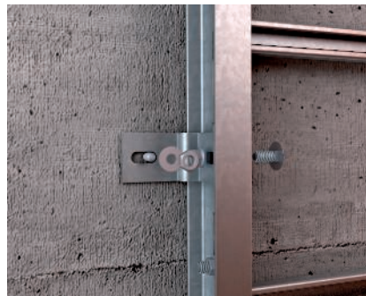
Mocowanie drabiny pionowej przemysłowej Przemysłową drabinę pionową mocuje się na ścianie za pomocą kątowników montażowych typu BW80/55.
