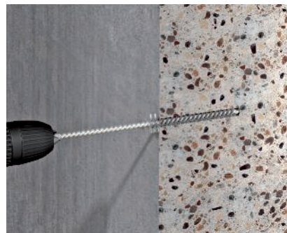
Czyszczenie szczotką drucianą Czyszczenie mechaniczne szczotką drucianą. Proces czyszczenia szczotką drucianą i wydmywania otworu należy wykonać dwukrotnie.
