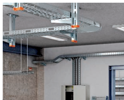
Montaż zamocowania sufitowego Prezentacja ostatecznego montażu sufitowego z korytkami kablowymi.
